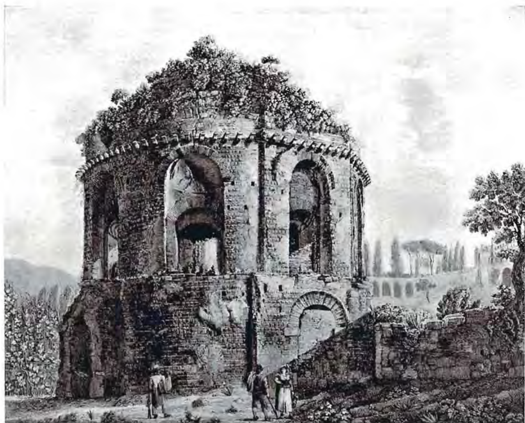
TEMPIO DELLA TOSSE
