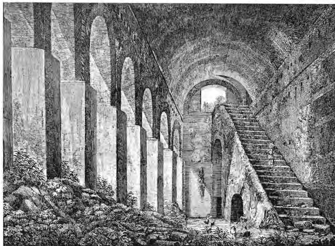
SERBATOIO IDRICO NELLA VILLA DOMIZIANEA
